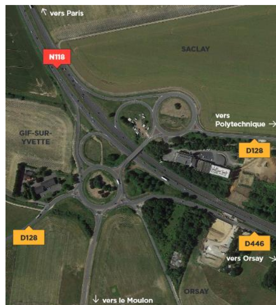
Echangeur de Corbeville (existant) (source: Etablissement Public d'Aménagement de Paris-Saclay)
